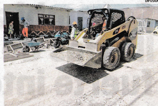
AVANZA EJECUCIÓN DE PISTAS Y VEREDAS EN EL INDIO.
